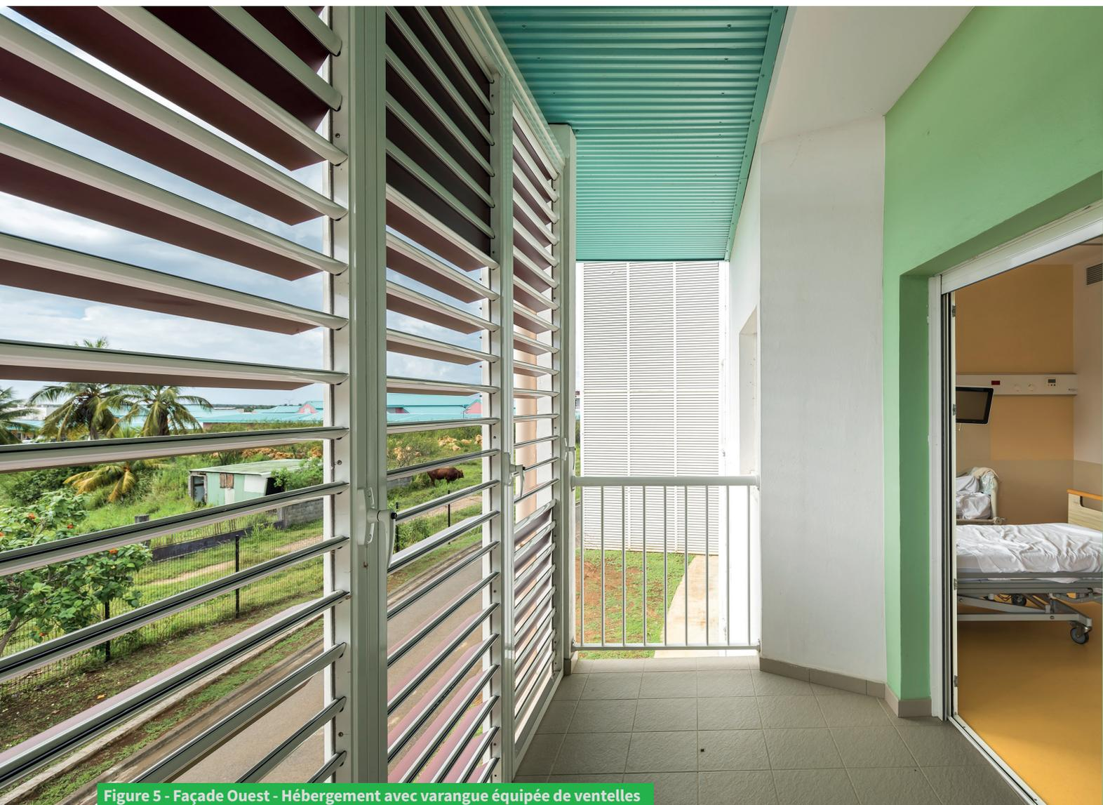
Figure 5 - Façade Ouest - Hébergement avec varangue équipée de ventelles
