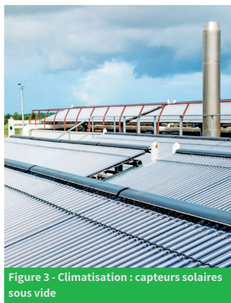
Figure 3 - Climatisation : capteurs solaires sous vide
